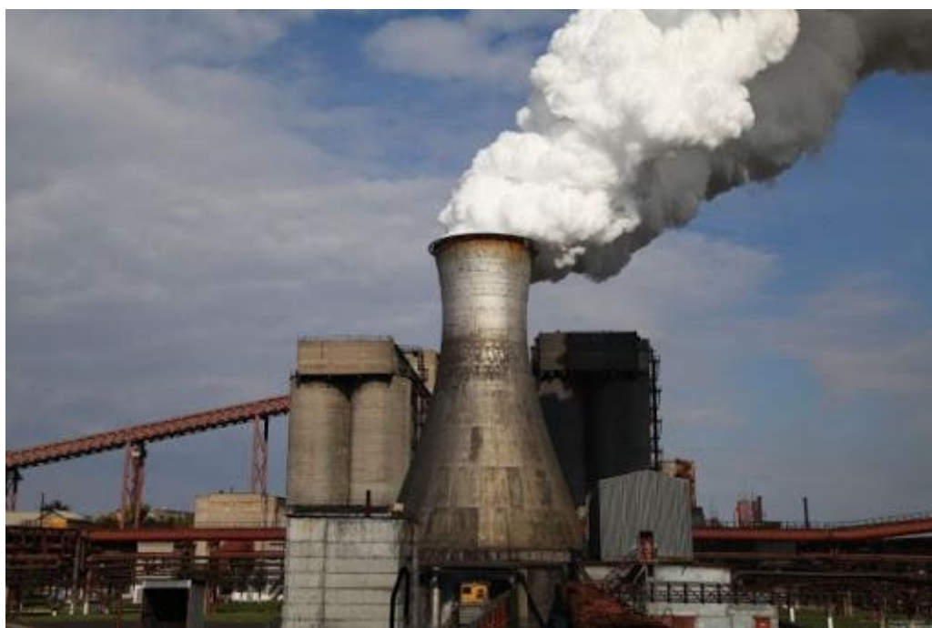
Рис.3.4. Викид пари з вежі гасіння при мокрому гасінні
