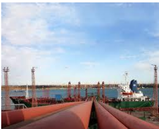
Рис. 1.13 - Перекачування аміаку з танкерів до резервуарів за допомогою трубопроводів.
