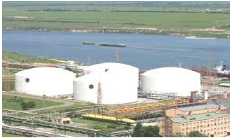
Рис.1.12 - Ємності для зберігання аміаку.
