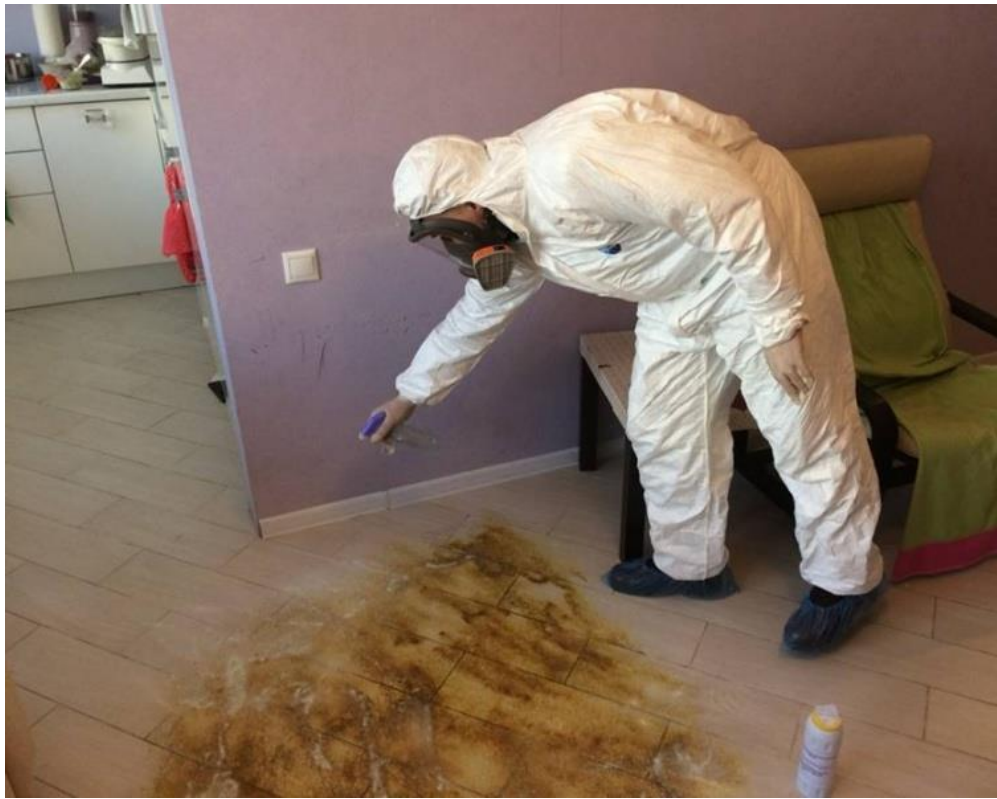
Рис.1.3 - Хімічний метод оброблення ртуті
