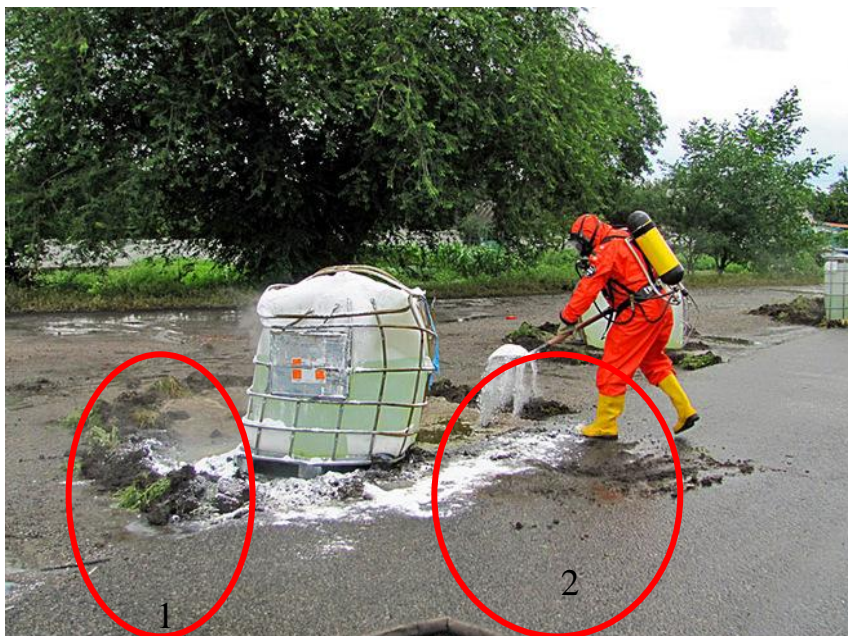
Рис. 2.4. Нейтралізація розлитої кислоти. 1 – обвалування; 2 – нейтралізація.
