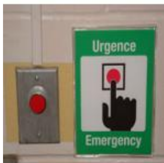
Рисунок 4.1. - Кнопка «Аварія» в лабораторії
