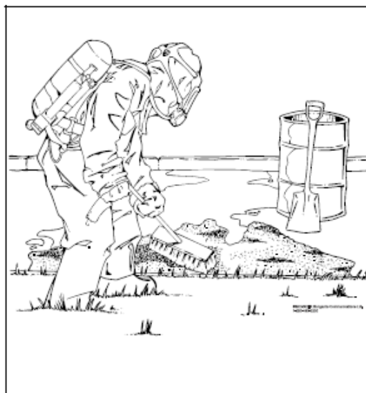
Рис. 3.4. Збирання забрудненого ґрунту
