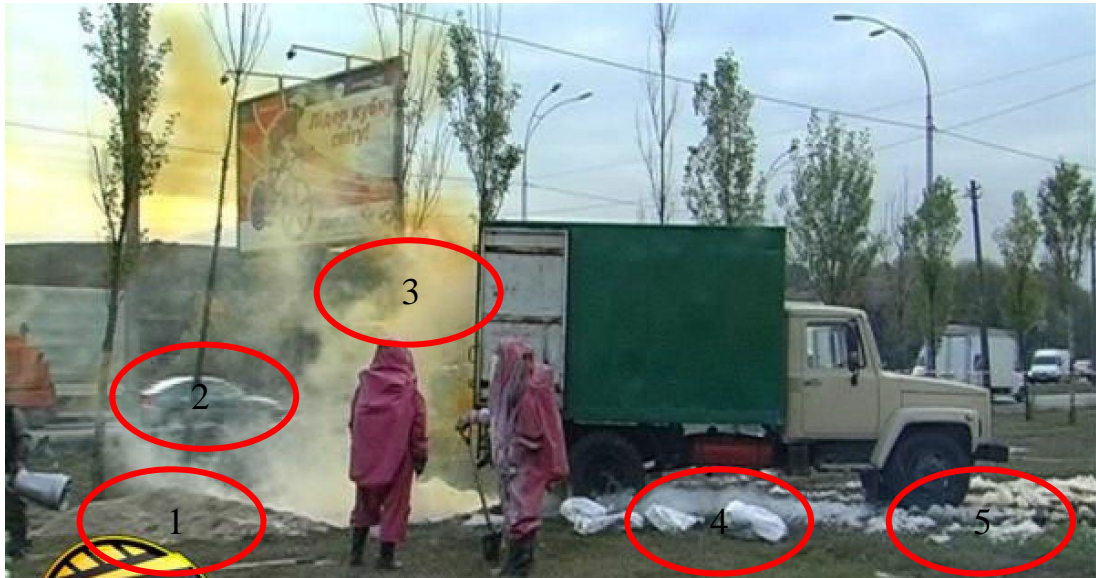
Рис. 2.2. Ліквідація аварії з розливом кислоти. 1 – обвалування; 2 – рух автотранспорту; 3 – випаровування кислоти; 4 – мішки з каустичною содою; 5 – повітряно-механічна піна.
