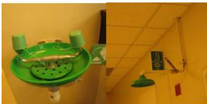
Рисунок 4.2. - Станції промивання очей та екстрені душі над дверима лабораторії
