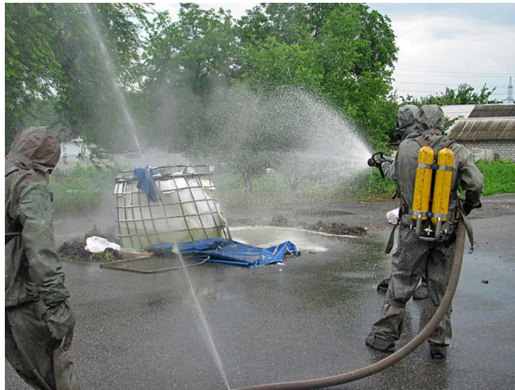
Рис. 2.3. Осадження хмари сірчаної кислоти водяною завісою
