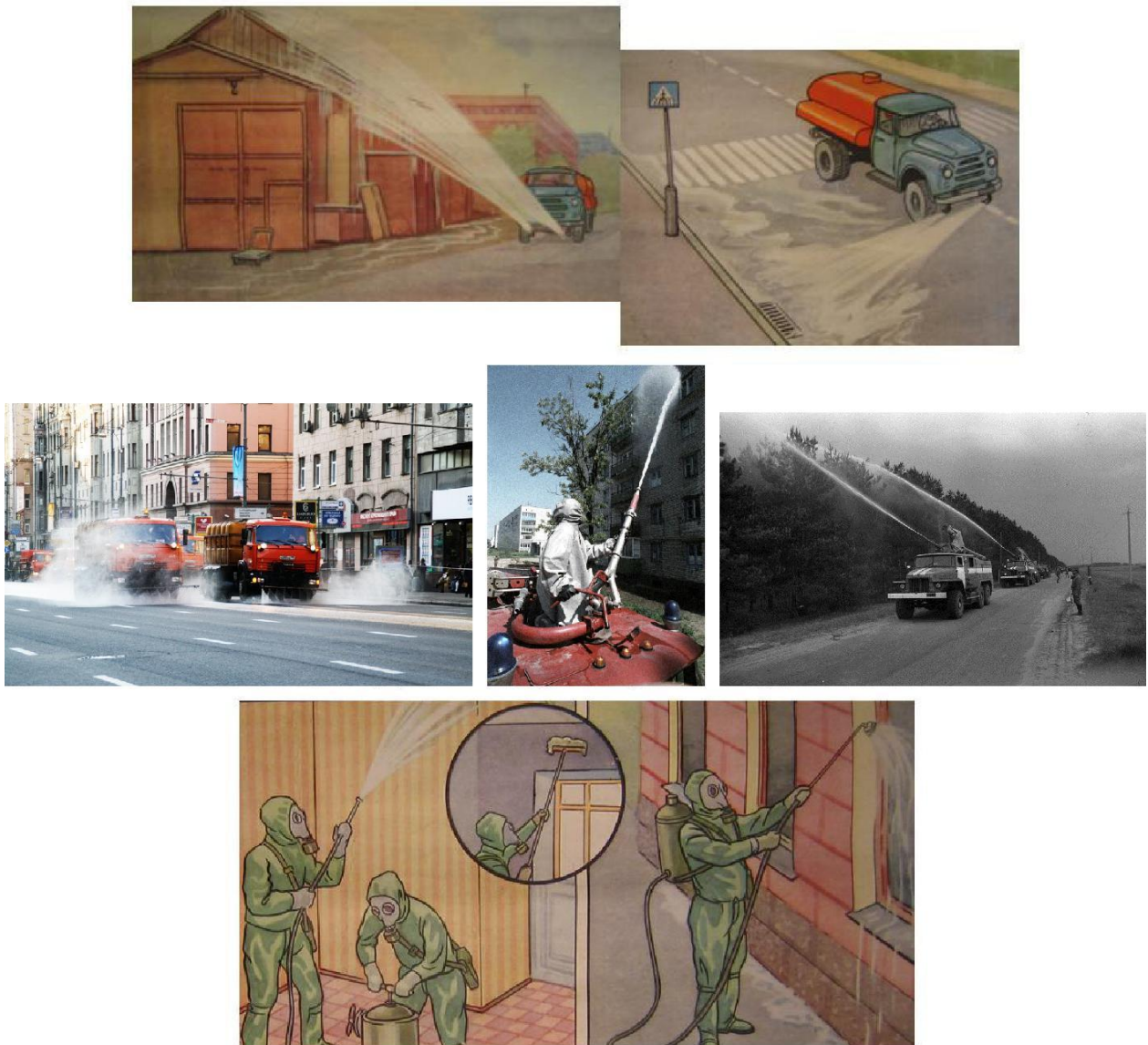
Рис. 2.10. Проведення спеціальної обробки споруд, доріг, житлових будинків та приміщень
