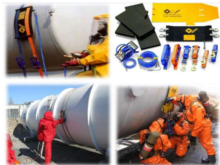
Рис. 2.6. – Ліквідація вилу (викиду) НХР за допомогою бандажів
