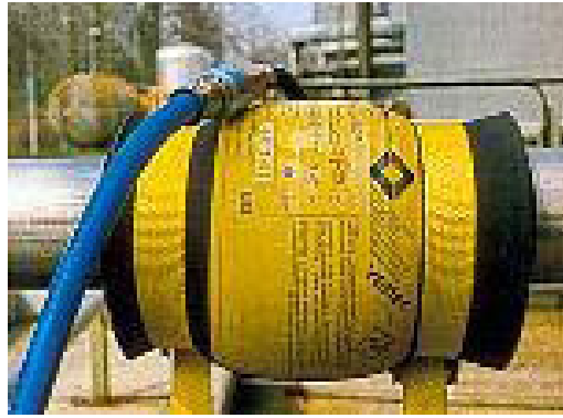
Рис. 3.7 – Герметизація трубопроводів
