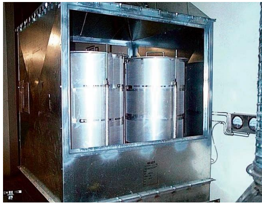
Рис. 3.2– Фільтрувальна установка з радіальними фільтрами продуктивністю 4000 куб.м/хв була обрана для сходової кімнати- укриття.
