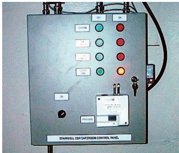
Рис.3.3 – Панель управління безпечної кімнати класу 1 має перемикач запуску/зупинки системи, індикатори стану заслінок і манометр.
