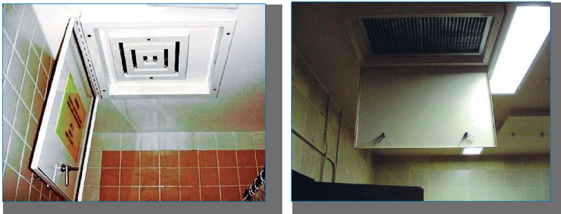
Рис. 2.1– Відкидні кришки забезпечують швидку герметизацію припливних, зворотних або витяжних каналів у безпечному приміщенні.
