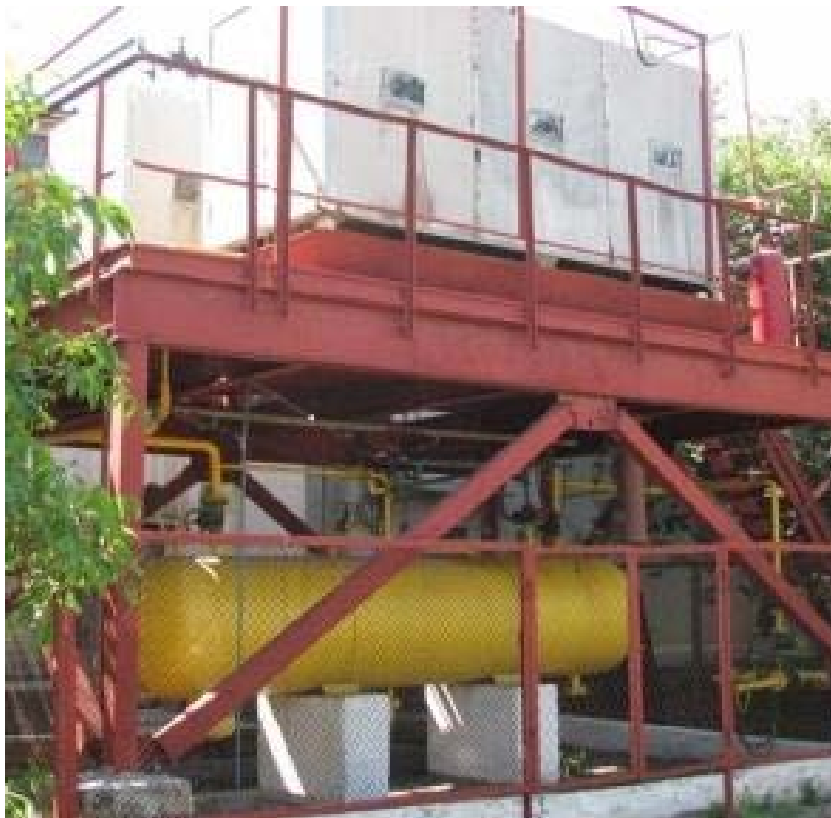
Рис 3.2 – Зовнішній вигляд лінійного ресиверу
